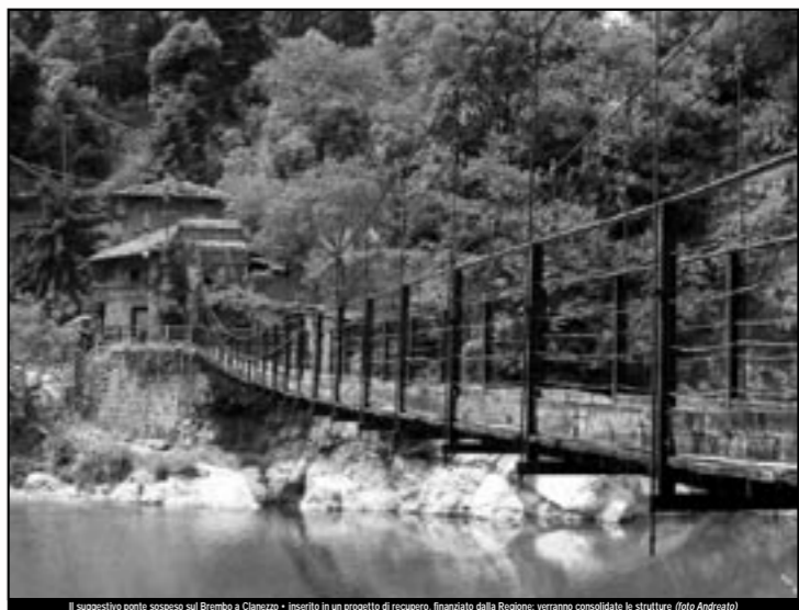
Il suggestivo porto sospeso sul Brembo a Clanezzo - inserito in un progetto di recupero, finanziato dalla Regione - verranno consolidate le strutture (foto Andreatto)
